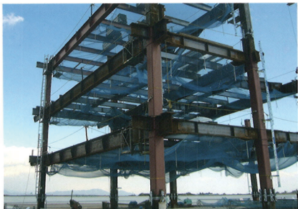
水平ネット 鉄骨組立時の墜転落を防止します。
