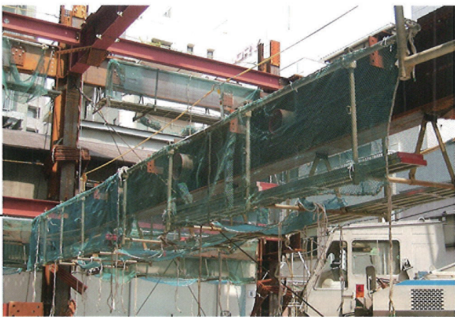
ハイステージ使用時 ハイステージの手すり間や足場板の隙間からの墜転落を防止します。
