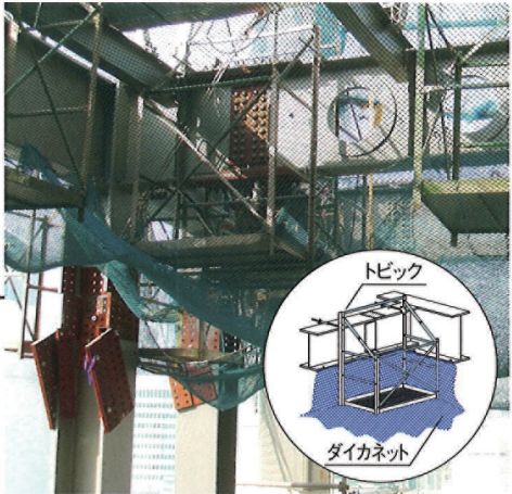
Tボック使用時 Tボック使用時も、Tボックの下を通してネットを張ることで安全を保てます。
